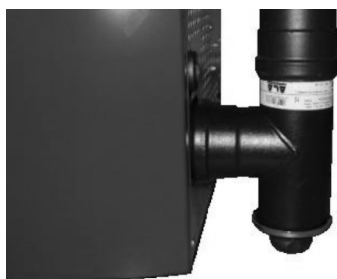
Fig. 28 - Czyszczenie czopucha
