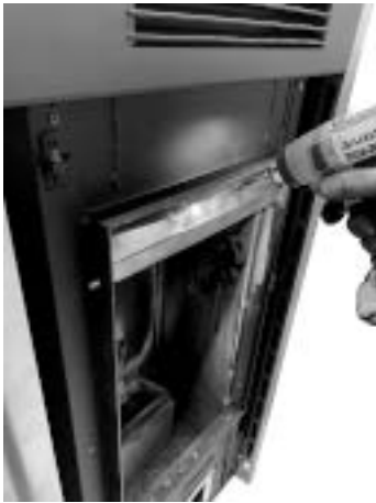
Rys. 118 - Zdjęcie deflektora
