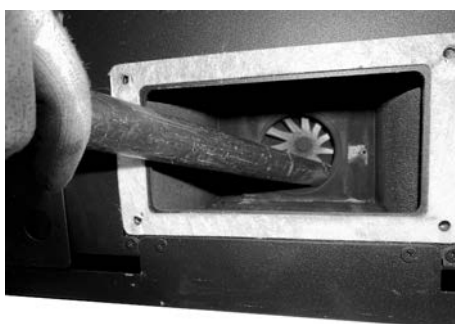
Rys. 129 - Odkurzanie popiołu
