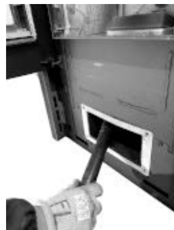
. 124 - Czyszczenie za pomocą środka do czyszczenia rur Rys. 125 - Odkurzenie popiołu
