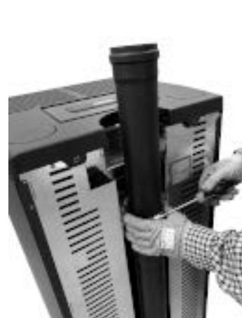
Rys. 73 - Montaż tylnego wyciągu oparów
