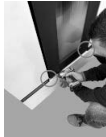
. 47 - Mocowanie dolnego panelu
