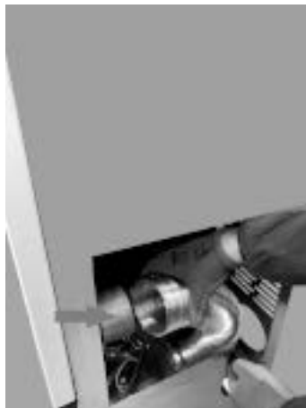
. 91 - Odłączanie węża
