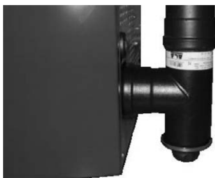
Rys. 117 - Czyszczenie kanału dymowego
