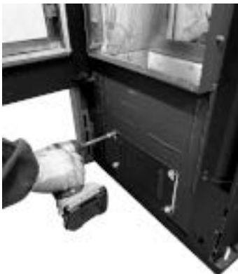
Rys. 126 - Zdejmiij zaślepkę
