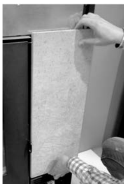
Rys. 60 - Zaczepianie kamieniaRys
