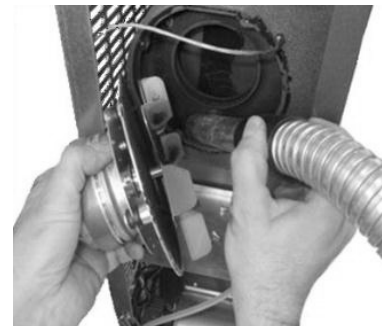
Fig. 56 - Czyszczenie odciaгу do dymu: faza 3
