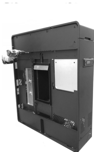
Fig. 36 - Demontaż profilu górnego
