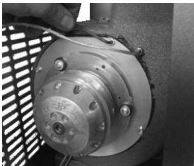
Fig. 54 - Czyszczenie odciaгу do dymu: faza 1
