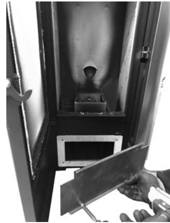
Fig. 43 - Usunąć zamknięcie rewizyjne.
