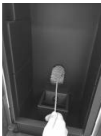
. 35 - Czyszczenie paleniska Rys. 36 - Czyszczenie za pomocą szczotki
